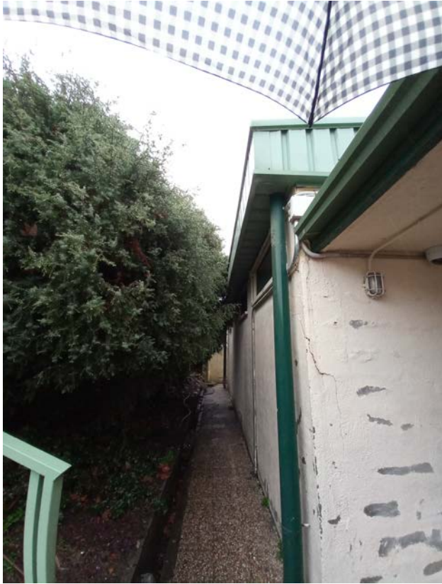
Borde de cubierta y canalón oculto sobre aseos
