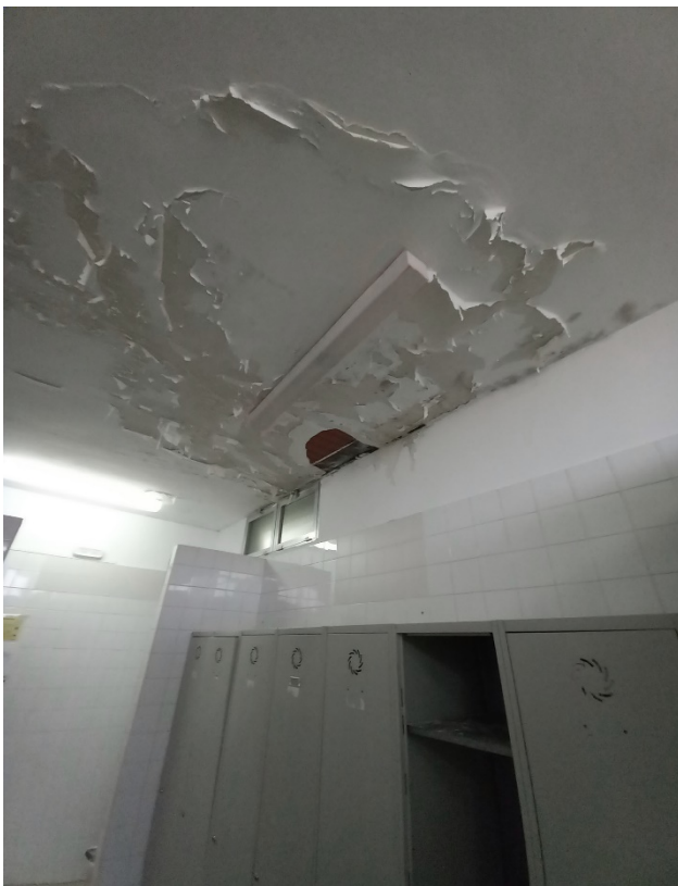
Falso techo deteriorado por filtraciones en aseo
