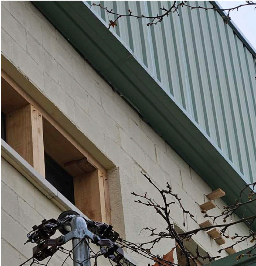
Refuerzos y cuñas en ventanas del pabellón de deportes
